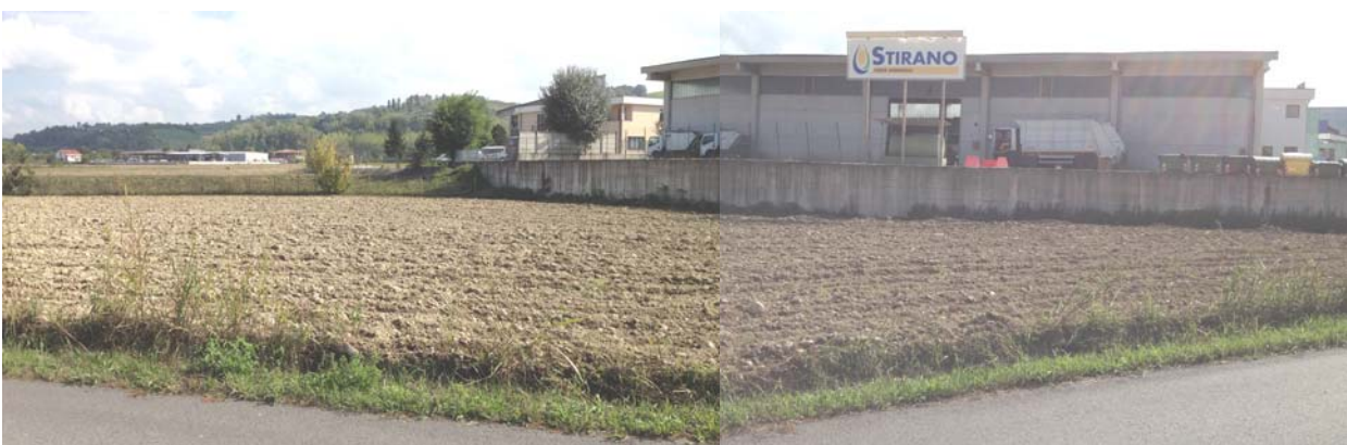
Foto 4 - Muro di contenimento del riporto dell'area produttiva, perimetrale all'antico paleoalveo, di altezza pari a circa 220 cm.
